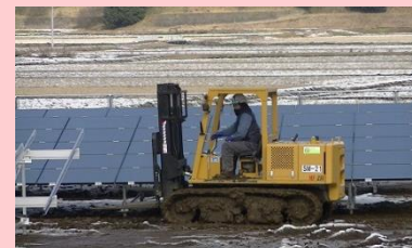
太陽光発電 ソーラパネル設置
