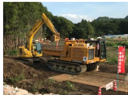
自動運転操作状況 (油圧ショベル(左)は操作員搭乗運転、クローラダンプ(右)は自動運転)
