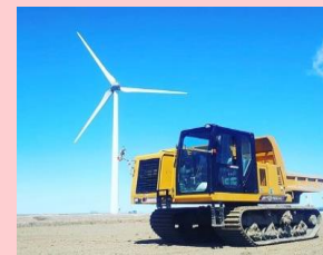
風力発電建設現場
