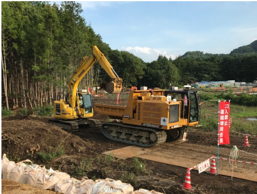
写真1 自動運転試験状況
